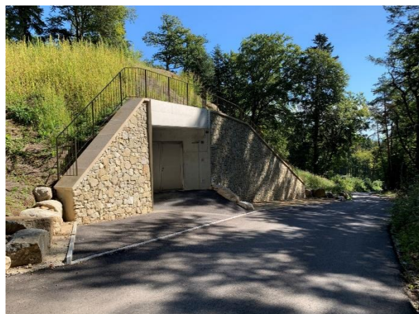
Réservoir de l'Essert
