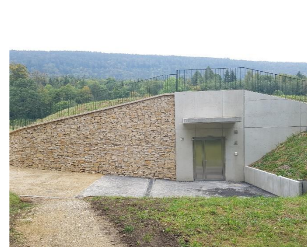
Station de pompage de Fontaine-André
