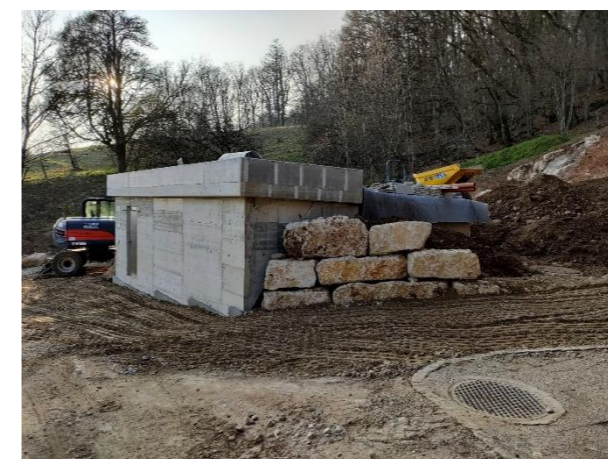
Réservoir de Combazin
