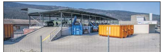
Déchetterie de l'Entre-deux-Lacs à Cornaux, du Syndicat intercommunal de la Châtellenie de Thielle.
